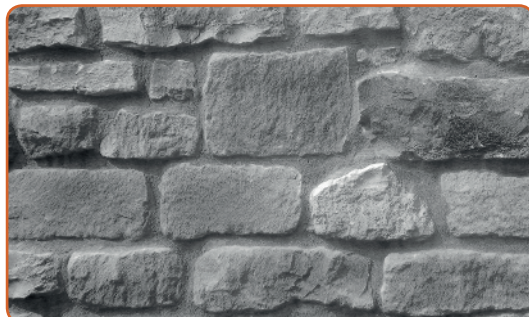
pose avec joints
