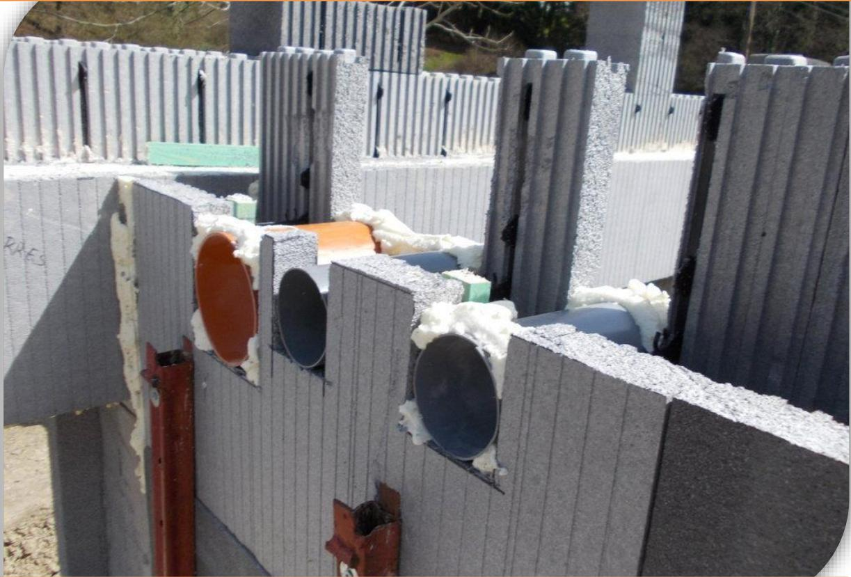
Les réservations se prévoient en découpant et posant les tuyaux avant le bétonnage.
