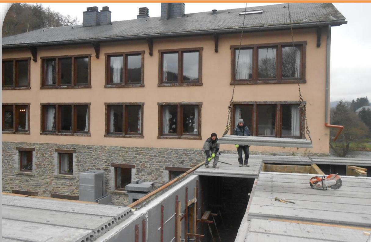
La pose des hourdis se réalise de façon traditionnelle sur le voile béton de 15 cm
