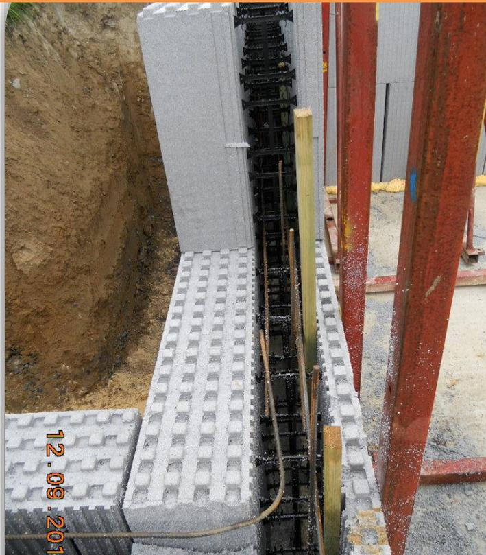
En partie enterré, un ferrailage spécifique peut être défini par l'étude. Des barres à béton peuvent être pliées et insérées au niveau des coins mais aussi lors de la jonction de murs pour une bonne liaison entre eux.
