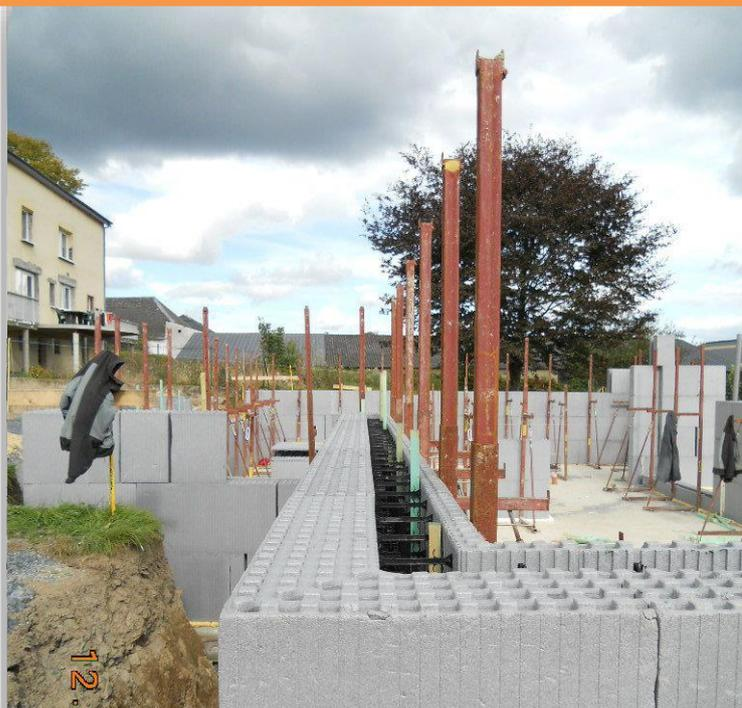
Tous les mètres, placez et fixez au sol un étais. Au fur et à mesure du montage des blocs, insérez une latte de toit dans les 15 cm prévu au voile béton. Assurez la rigidité de la paroi
