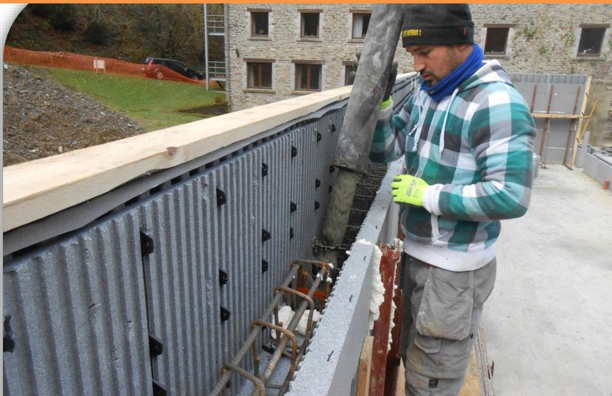
Réglez la rectitude de votre mur à l'aide de la vis sans fin de l'étais. Pour le bétonnage, il sera demandé au pompiste de mettre une réduction au niveau du tuyau de béton afin de diminuer la pression du béton. Le type de béton C25/30.
