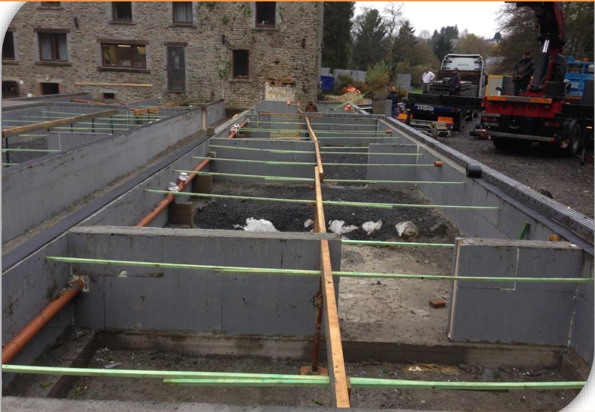
Dans le cas de vide ventilé, les blocs peuvent être bétonné jusqu'à 1m50 sans étayage.
