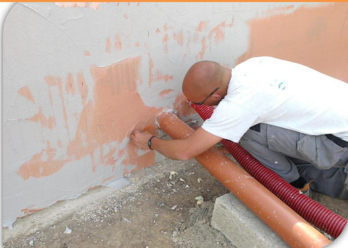
Pour les parties enterrées, un cimentage type Caparol 190 avec trame est réalisé. Ensuite, un enduit d'étanchéité souple est mis en œuvre (Type Masterseal 6100).
