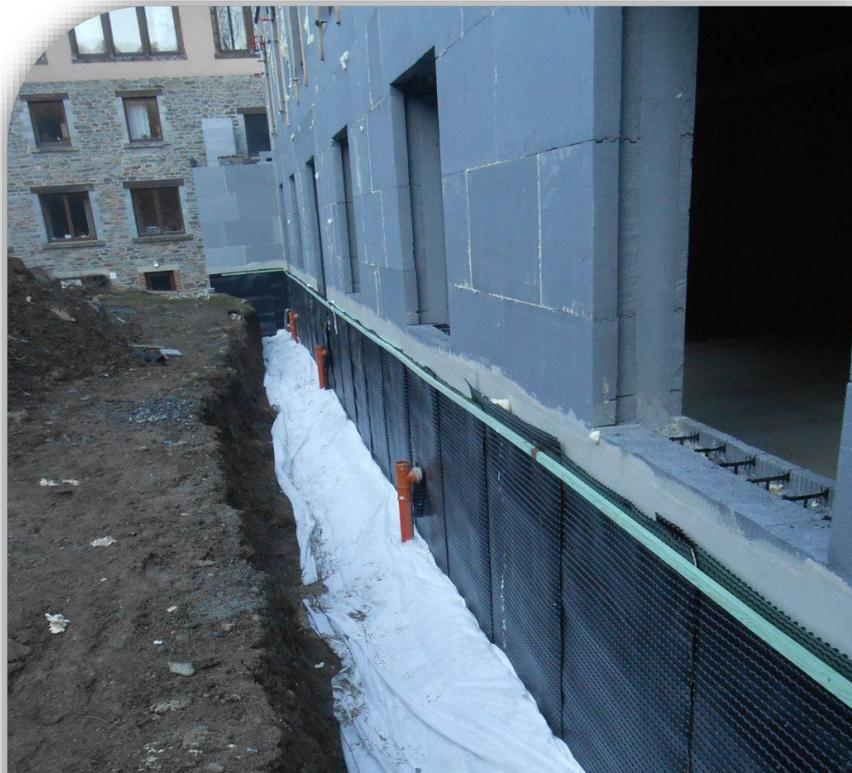
Le Platon protégeant l'étanchéité lors du remblayage sera fixé en le coinçant entre 2 lattes de toit fixé au bloc au dessus du niveau des terres. De cette manière, l'étanchéité reste parfaite puisqu'aucune fixation n'est placée sous le niveau de terre fini.
