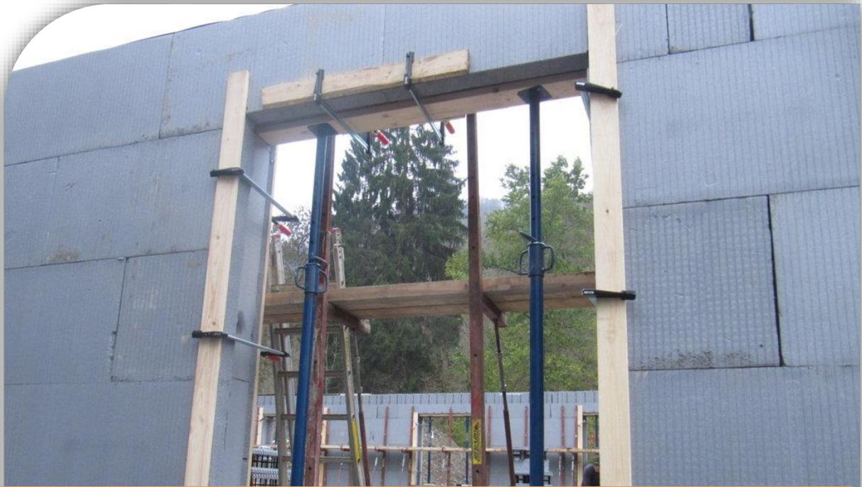
Pour les baies, découpez vos blocs à l'aide d'une scie égoïne ou d'une tronçonneuse. Une volige de part et d'autre du bloc maintenue à l'aide d'un serre-joint permet de serrer le bouchon et d'éviter l'ouverture du bloc. Le linteau en Neopor sera, quant à lui, maintenu en place à l'aide d'étauçons. N'oubliez pas de découper la battée avant de placer le bloc.
