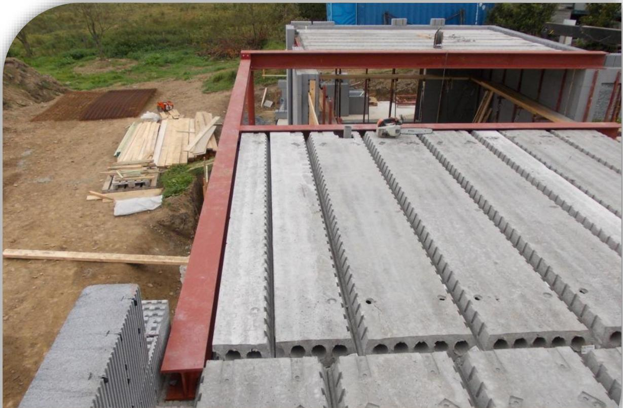
La pose de poutrelle pour différent assemblage est aisée. Ne coupez pas l'isolant extérieur, il servira d'arrêt béton pour la chape de compression. De plus, il permettra d'emboîter le tas de l'étage suivant directement dessus, assurant une continuité de l'isolation.
