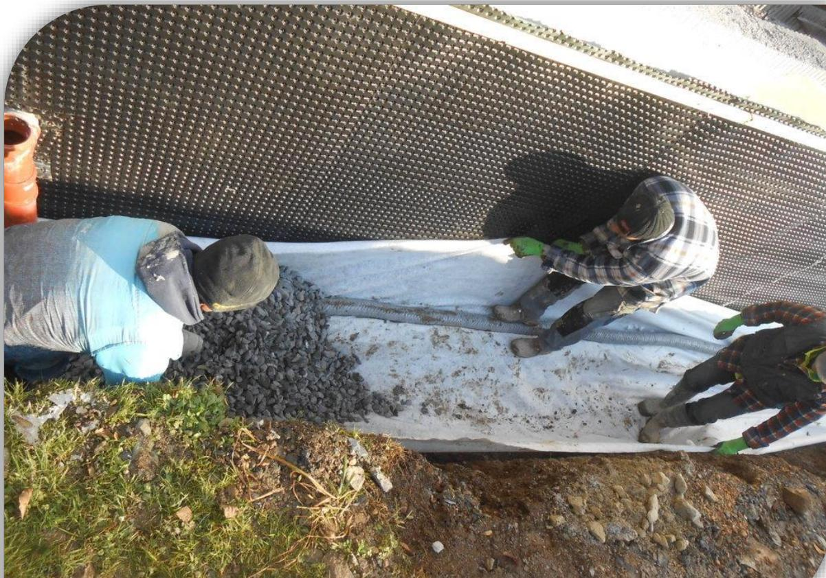
Le drain guidé dans la coulisse est recouvert par l'empierrement lequel est enrobé d'un géotextile.
