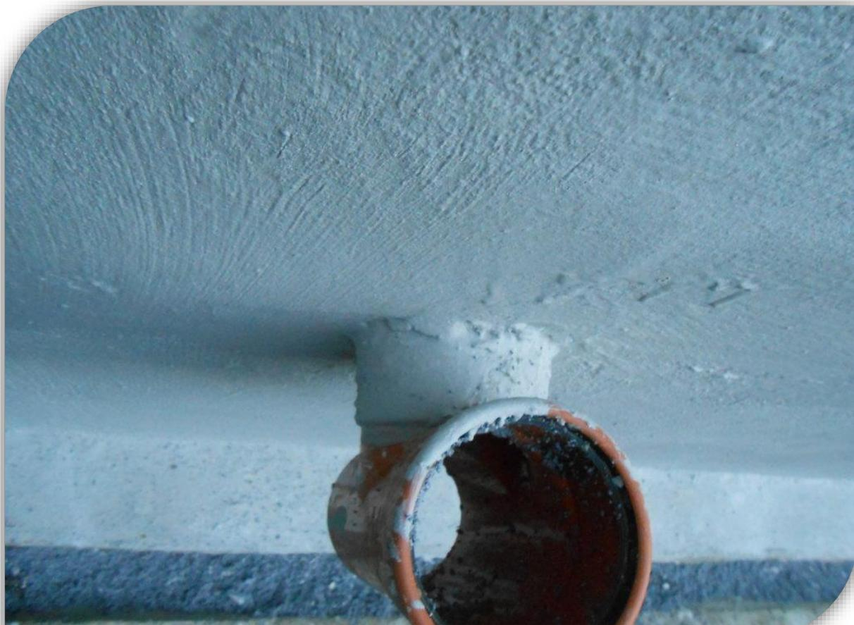
Une fois sec, le Masterseal 6100 forme une couche « flexible » et « plastifiée ». Il assure ainsi une étanchéité parfaite tant sur les surfaces planes qu' autour d' une réservation.
