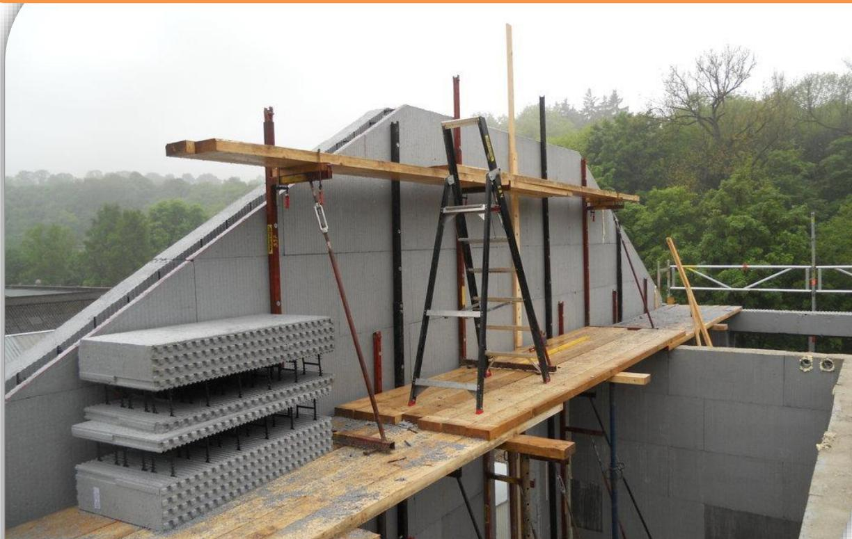
Pour le bétonnage des pointes, il faut reprendre à la truelle le béton et le lisser en pente.
