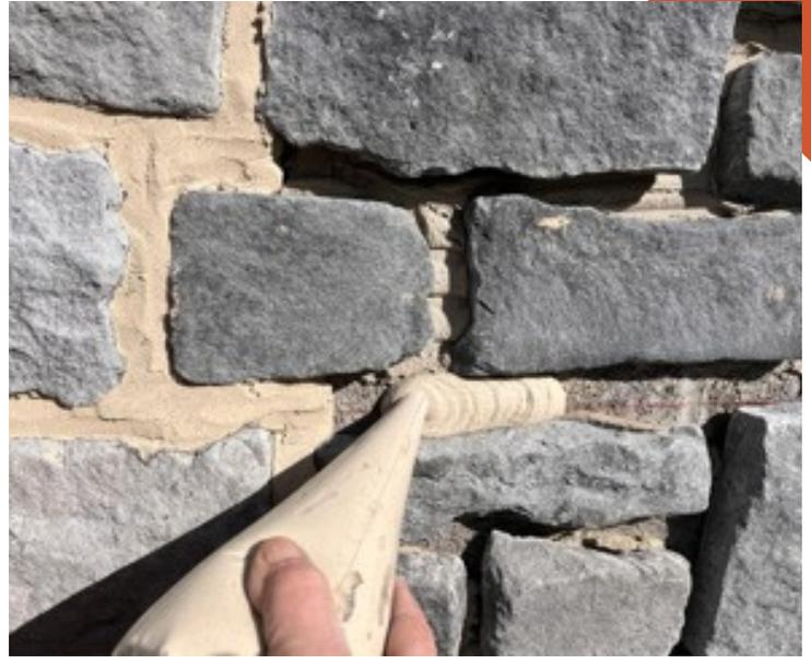
**24 heures après la pose**, procédez au jointoiment. Préparez le mortier de jointoiment à l'aide d'un malaxeur. Remplissez les joints entre les pierres. Lorsque le joint commence à durcir, retirez l'excédent avec un fer à joint. Lorsque le joint est presque sec, vous pouvez, sans toucher la pierre, **lisser le joint à l'aide d'un pinceau propre et sec**, afin de retirer les traces de fer à joint.
