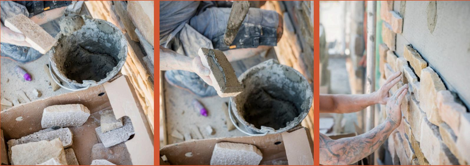
Appliquez de façon **homogène** le ciment colle avec une spatule dentelée sur le mur préparé par petite surface au fur et à mesure de l'avancement, appliquez une fine couche de ciment colle au dos de la pierre et appuyez-la fermement sur la surface. Le double encollage est fortement conseillé.
