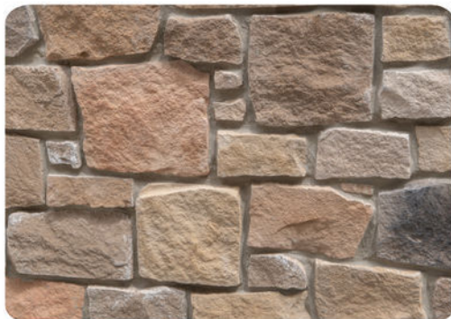
Pose avec joint
